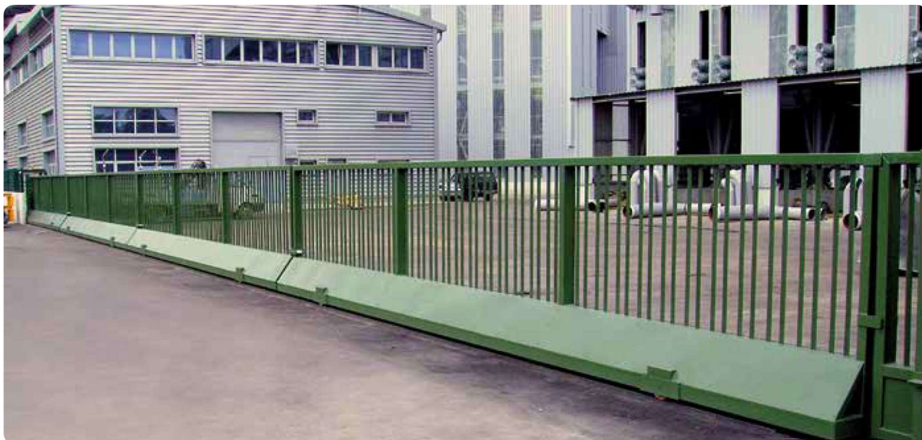
Corredera cancela motorizada de 40 metros de luz.
